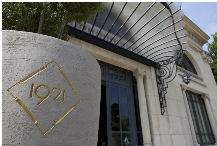
Entrée de la Villa Collet © Cité du Champagne
